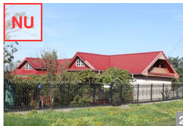
AȘA NU: Mansardare cu crearea unor volume de acoperiș nespecifice, ieșite în consolă față de parter.
