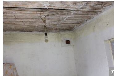
7 Structuri de tavane lutuite, din șipci de lemn una lângă alta, sau din stuf legat pe șipci mai rare, bătute sub căpriori.
