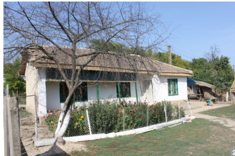
Tipologii planimetrice – casă tricolulară din Istria, jud. Constanța, cu prispă îngustă pe două treimi din fațadă și sală (tindă) retrasă. Camerele sunt egale. Intrarea în casă se face în mod atipic pe dreapta, în una din camerele laterale. Stâlpii sunt din lemn. Nu există parapet, înălțimea permițând acest lucru.
