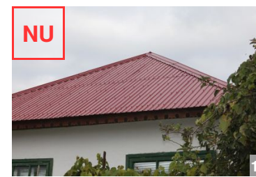
AȘA NU: Învelitoare din panouri de tablă, incompatibile vizual cu pizia de lemn traforat.
