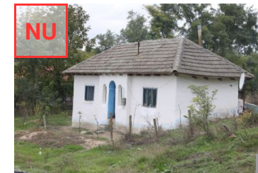
AȘA NU: Lipsa trotuarului a condus la deteriorarea pereților în partea inferioară.
