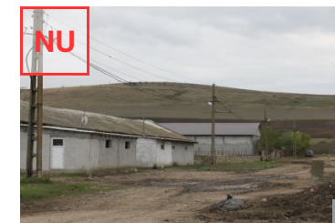
AȘA NU: Zidăria din BCA, cu tencuială pe bază de ciment, nu se recomandă nici la clădirile cu gabarite mari.
