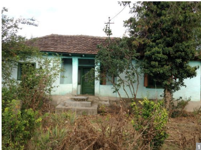
Tipologii planimetrice – casă tricolulară din Floriile, com. Aliman, jud. Constanța, cu prispă îngustă pe centru și sală (tindă) retrasă. Camerele sunt egale. Intrarea pe prispă e marcată de doi stâlpi zidiți. Tipologia este mai întâlnită în Podișul Dobrogei de Sud.
