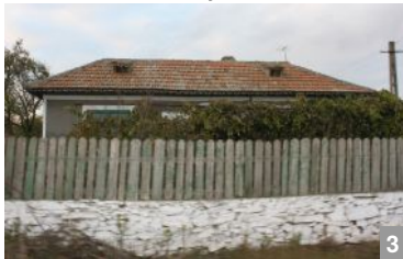
3 Mici lucarne în acoperiș de țiglă, sat Neatârănarea, comuna Beidaud, jud. Tulcea
