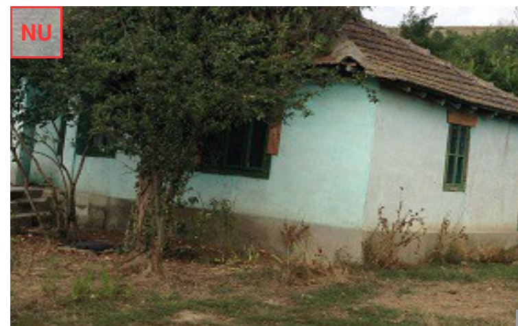
AȘA NU: Socluri tencuite cu mortar de ciment.
