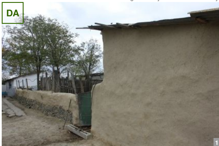
AȘA DA: Casă de chirpici și gard de piatră pregătite pentru iarnă, reparate cu lut amestecat cu paie mărunțite, în satul Runcu, comuna Pantelimon, jud. Constanța.
