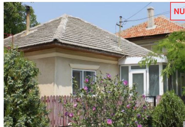
NU AȘA NU: Imagine distonantă creată de extinderea acestei case, la renovare, cu o construcție aparent provizorie, din tâmplărie de PVC, cu acoperire nerelaționată corect cu acoperișul principal.
