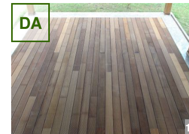
AȘA DA: Pardoseală exterioară modernă de terasă și prispă.
