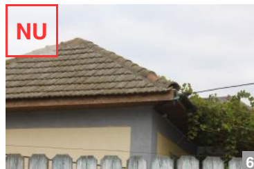
AȘA NU: Pазie realizată din OSB, nefinisat – se recomandă cea din lemn, cu console expuse
