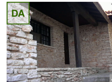
ASA DA: Se recomandă, în zonele de tradiție, să se recurgă tot la construirea cu zidărie de piatră, posibil aparentă, care poate fi îmbunătățită ca izolare termică cu un strat intermediar termoizolant (alcătuire triplă).
