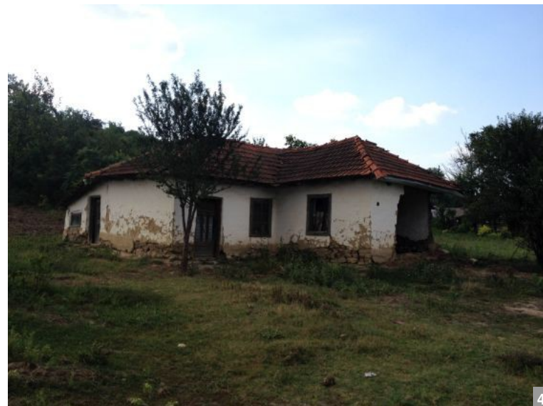
Tipologii planimetrice – casă tricolulară din Floriile, com. Aliman, jud. Constanța, fără prispă, în formă de „L”, cu anexă pe latura opusă intrării.
