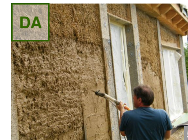
ASA DA: Aplicarea tencuielii se poate face cu mijloace mecanizate.
