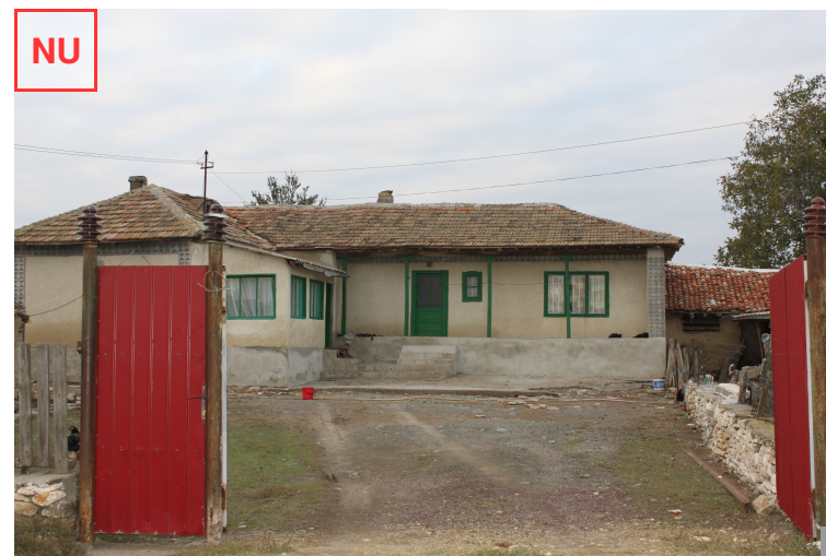
AȘA NU: Lipsa trotuarului a condus la deteriorarea pereților în partea inferioară.
