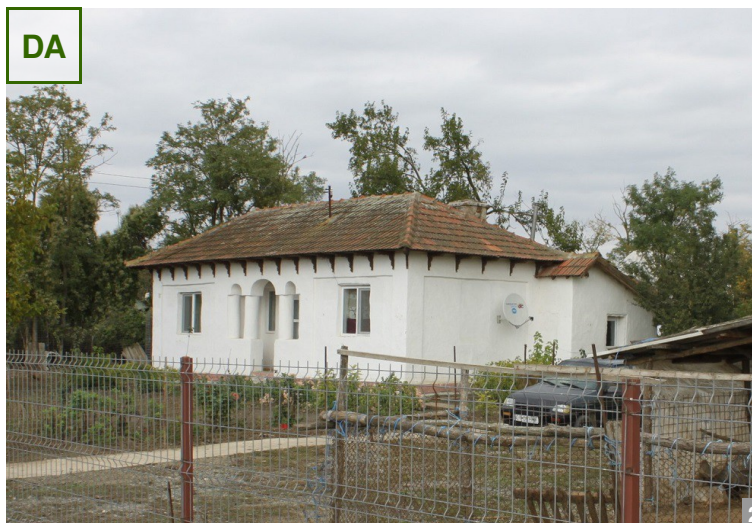
DA AȘA DA: Prin renovare, s-au păstrat volumetria, s-au folosit construcțiile anexe pentru îmbunătățirea funcțională, s-au refăcut elementele decortive de lemn de la streșină, s-au menținut șarpanta și învelitoarea.
