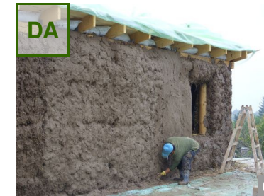
ASA DA: Tencuirea casei din baloți de paie, din chirpici sau piatră cu lut.
