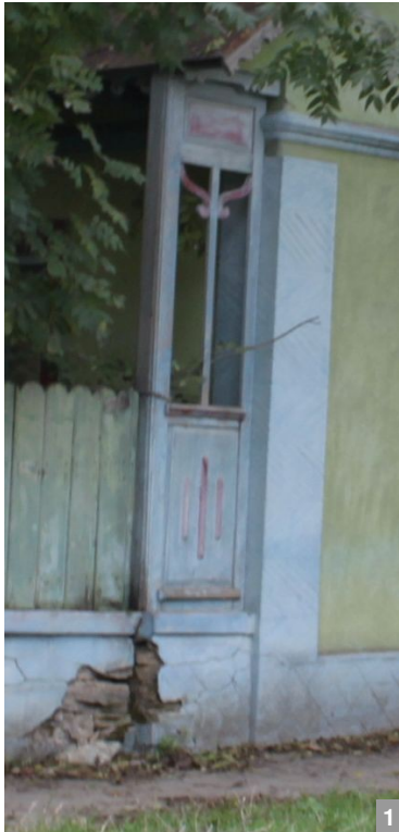
1 Panouri decorative din lemn pentru capătul prispei dinspre stradă, în Slava Cercheză, jud. Tulcea.
