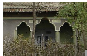
Prispă centrală, cu doi stâlpi și două coloane semiangajate zidite, în satul Mireasa, comuna Târgușor, jud. Constanța.
