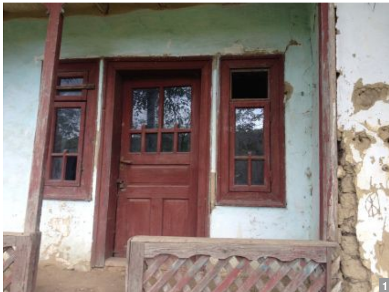
1 Ferește cu câte două canaturi inegale suprapuse, adiacente ușii cu geam, subîmpărțite în ochiuri cu șprosuri subțiri de lemn, în satul Floriile, comuna Aliman, jud. Constanța.
