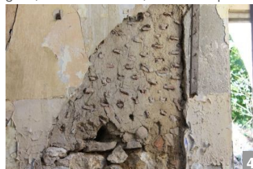
Detaliu de execuție pentru perete de ceamur întărit cu bucăți de ceramică arsă.
