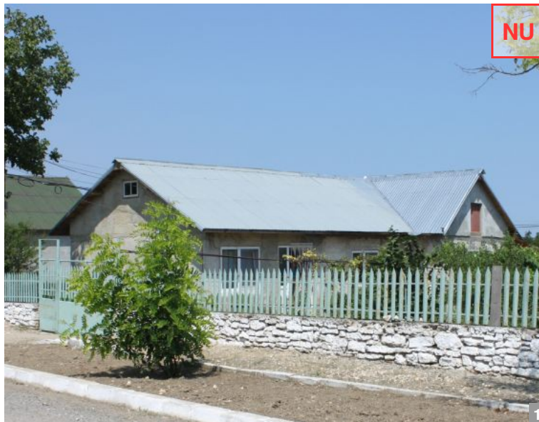
AȘA NU: Acoperiș simplu ca formă, respectă panta caracteristică zonei, totuși cu înclinații diferite la cele două frontoane și cu învelitoare nepotrivită.
