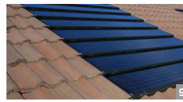
AȘA DA: Amplasarea panourilor voltaice integrate sau a panourilor solare de formatul olanei sau țiglei va fi, în viitor, soluția optimă.
