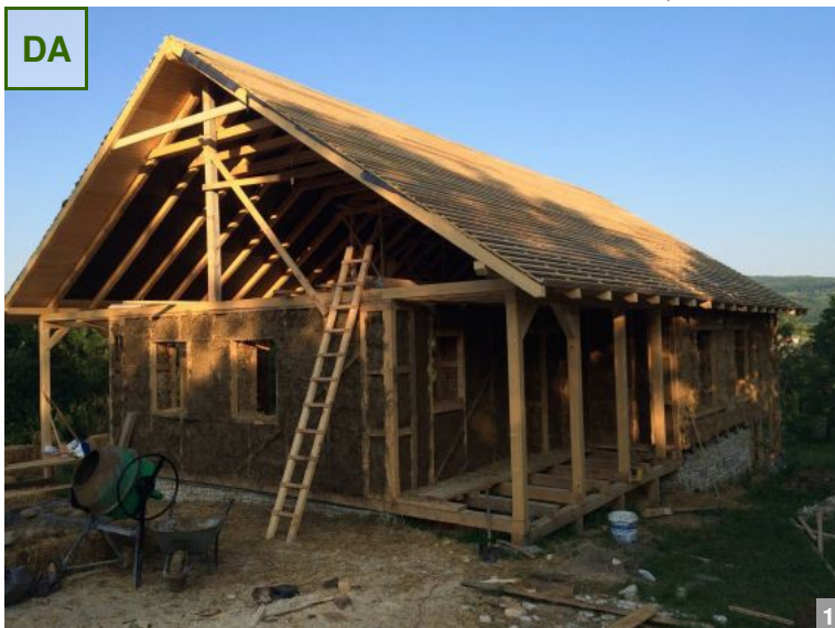
ASA DA: Construcție nouă cu pereți din baloți de paie cu structură de lemn.
