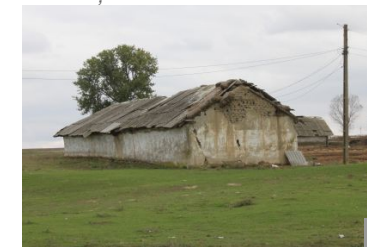
Chirpicul poate fi folosit cu încredere pentru construcții de gabarit mare, cum se folosea odinioară.
