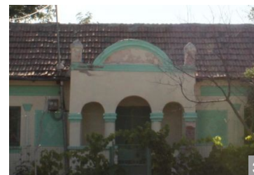
Prispă centrală ca registru vertical, ieșită din planul fațadei, cu fronton fără modificarea acoperișului, la Săcele, jud. Constanța.
