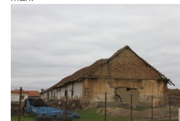
Zidăria din cărămidă, chiar produsă industrial, este recomandată spre a fi folosită la închideri de clădiri agricole de dimensiuni mari, așa cum se folosea și în trecut.
