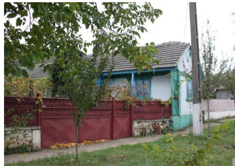
Locuință tradițională din nordul Dobrogei, renovată, fără modificări de șarpantă, înălțime sau goluri, cu păstrarea aspectului tradițional. Împrejmuirea, păstrând parapetul original din piatră, a fost totuși completată, nespecific, cu panouri metalice, vopsite în culoare nepotrivită.
