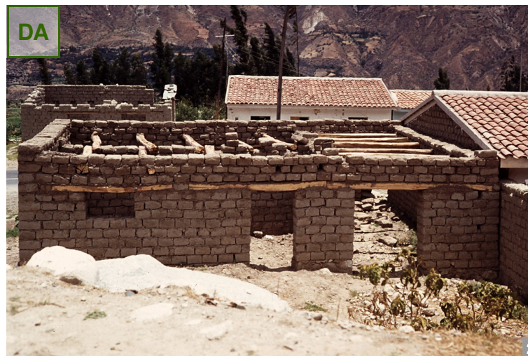
ASA DA: Materialele de construcție tradiționale, precum chirpicul, pot fi și astăzi confecționate la fața locului și puse în operă, în special pentru construcții mai mici, dar nu numai.
