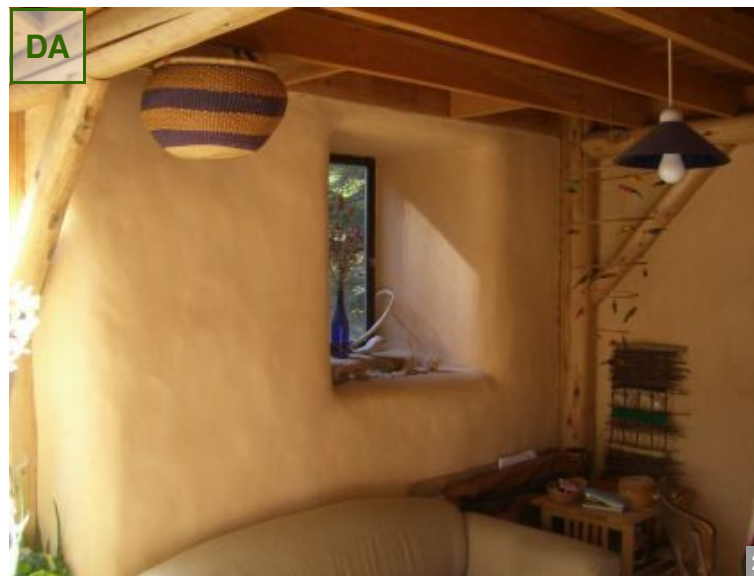
AȘA DA: Posibilitate de reparare la interior a construcțiilor existente cu materiale naturale, aplicate manual, obținându-se astfel un interior cald și primitor.
