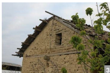
Casă zidită din chirpici, cu acoperiș în două ape, cu fronton tot din chirpici, în satul Caugagia, comuna Baia, jud. Tulcea.
