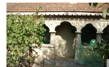
Parapet și stâlpi zidiți, în comuna Târgușor, jud. Constanța.
