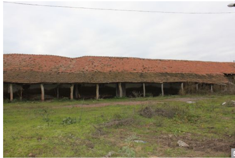
5 Construcție scundă, de gabarit mare cu șarpantă de lemn în două ape și învelitoare din țiglă ceramică, cu șopron adosat pe latura lungă, cu acoperiș în continuarea celui principal.
