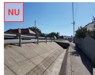
NU AȘA NU: Tratate necorespunzătoare a acostamentului străzii. Nu se recomandă asfaltarea sau betonarea nefundamentată, vegetația și mobilierul dispărând complet.
