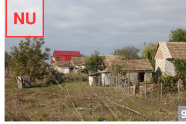
AȘA NU: Incompatibilitate de aspect, prin culoare, material și volumetrie a acoperișului în cadrul unui grup de clădiri tradiționale.
