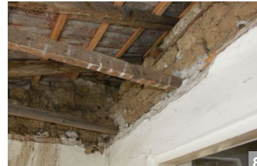
6 Șarpantă de lemn pe scaune, fără astereală, cu țigla așezată direct pe șipci.
