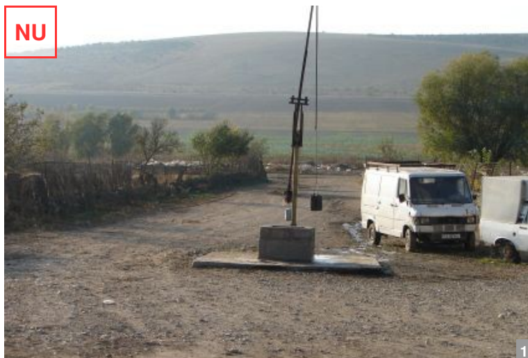
NU AȘA NU: Betonare și amenajare incomodă a platformei din jurul fântâniei.
