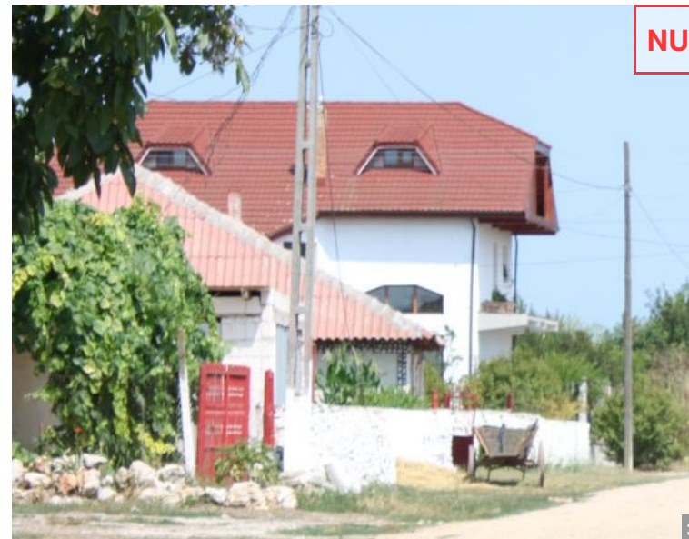
AȘA NU: Intervenție brutală, total nepotrivită ca aliniament la cornișă, regim de înălțime, volumetria acoperișului, și totuși des întâlnită în satele din zona marilor orașe, sau cu potențial turistic.
