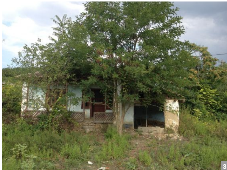
Tipologii planimetrice – casă bicelulară din Floriile, com. Aliman, jud. Constanța, cu prispă îngustă pe toată lungimea și anexă laterală pe toată lățimea casei. Prispă are stâlpii și parapetul din lemn.
