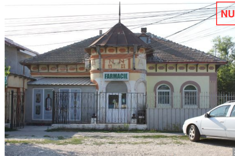
NU AȘA NU: Extinderea acestei case de țaran mai înstărit dintr-o localitate din centrul Dobrogei, precum și tratarea diferită a părților de fațadă, probabil din cauză că are la ora actuală mai mulți proprietari, au adus un deserviciu total clădirii. Se mai remarcă, tot în sens negativ, caseta firmei, care, evitând să fie suprapusă peste profilul decorativ, acoperă parțial arcada golului de la parter.
