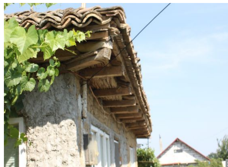
Acoperiș multistrat, din stuf și olană, la Istria, jud. Constanța
