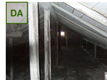
AȘA DA: Pod întunecos, rămas sub șarpanta de lemn cu astereală, folosit pentru depozitare. Termoizolarea se poate face între câpriori sau pe pardoseală, în funcție de utilizare.
