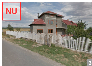
AȘA NU: Zidăria, probabil de BCA, cu tencuială pe bază de ciment, sunt soluții nerecomandate.
