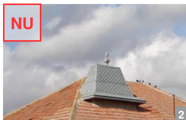
AȘA NU: Turnuleț care nu își are locul pe acest acoperiș.
