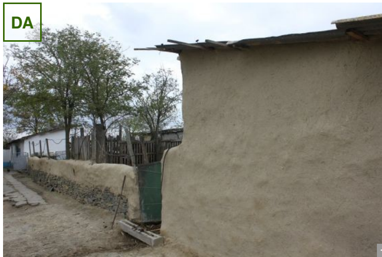
DA AȘA DA: Intervenții regulate de întreținere a zidăriei de chirpici, a soclului și a celei de piatră de la gard, prin aplicarea unui strat de pământ galben amestecat cu paie măcinate fin.
