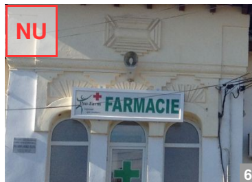
AȘA NU: Proiector și firmă luminoasă amplasate în mod defectuos fără a se ține cont de goluri și de ornamentele fațadei.
