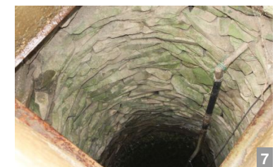
AȘA DA: Instalație nouă de aprovizionare cu apă, din fântână existentă, în Runcu, jud. Conștanța.
