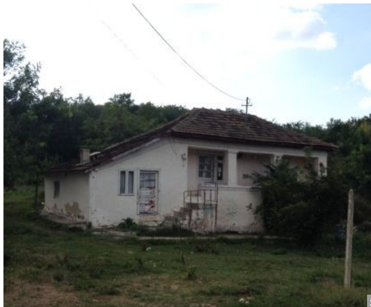
Soclu înalt de piatră, datorat reliefului înclinat în satul Floriile, comuna Aliman, jud. Constanța.
