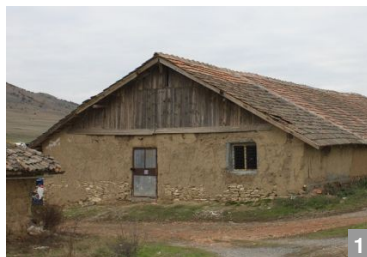
Soclu de piatră la o hală agricolă, pentru protejarea pereților din chirpici împotriva umidității din sol, în satul Lulia, comuna Izvoarele, jud. Tulcea.
