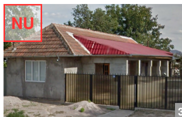
AȘA NU: Soluție nepotrivită de rezolvare a acoperișului în urma extinderii.
