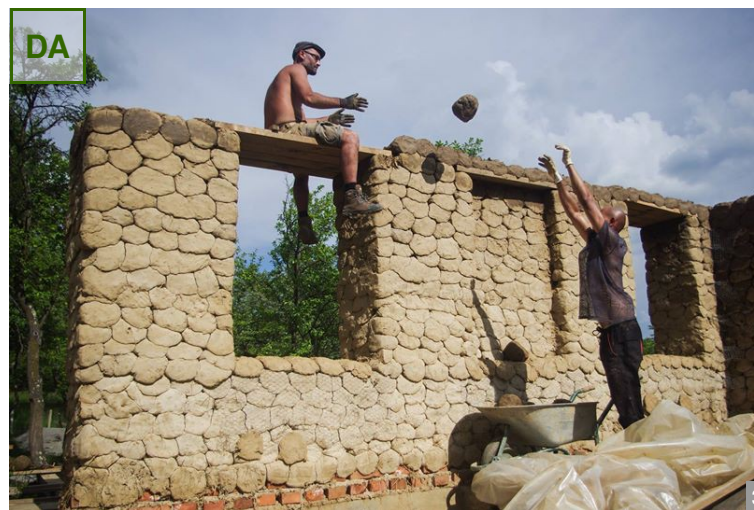
ASA DA: Construcție nouă cu pereți din ceamur, care poate avea orice configurație planimetrică, chiar și în detaliu.
