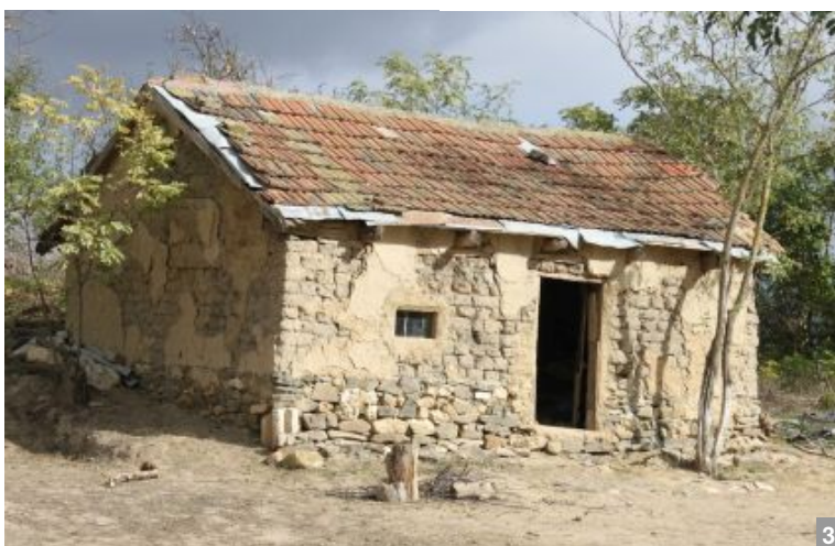
Anexă gospodărească construită cu fundație de piatră, pereți din chirpici și învelitoare de țiglă, în satul Mireasa, comuna Târgușor, jud. Constanța.
