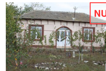
AȘA NU: Tâmplărie de PVC, de culoare diferită de cea a ansamblului, cu împărțire aleatorie a canaturilor și ochiurilor de geam de la ușă.
