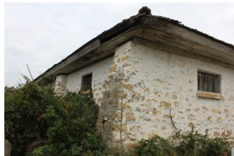
Construcție agricolă cu gabarit mare realizată din pereți masivi din piatră, în comuna Slava Cercheză, jud. Constanța.
