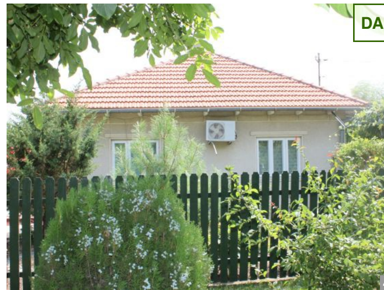
AȘA DA: Refacere corectă a acoperișului, fără modificarea volumetriei acestuia și a culorii pale cărămizii specifice țiglei ceramice tradiționale.
