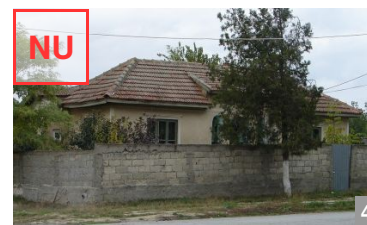
AȘA NU: Gard din bca și beton armat și poartă din tablă galvanizată.
