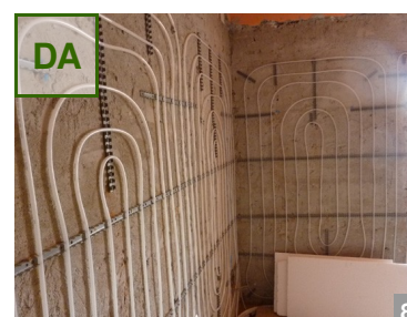
ASA DA: Folosirea unui sistem de încălzire în pereții exteriori în planul tencuielii este o metodă deosebit de eficientă și elegantă de încălzire. Încălzind zidurile groase, cu inerție termică mare, întreaga construcție se comportă ca o teracotă. Sistemul are însă și dezavantajul că nu permite lipirea mobilierului de peretele în cauză și necesită atenție sporită atunci când se bate un cui în perete.
