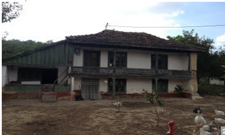
Casă cu etaj, prispe, stâlpi de lemn și anexă laterală – Floriile, com. Aliman, jud. Constanța
