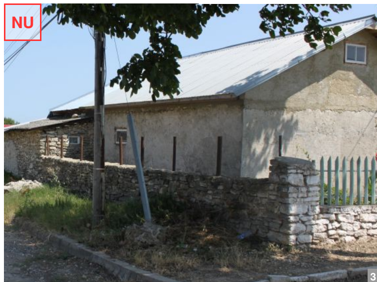
AȘA NU: Intenția bună de păstrare a unei zidării originale de piatră și a volumetriei acoperișului specifică locului este compromisă de înlocuirea nepotrivită a învelitorii.
