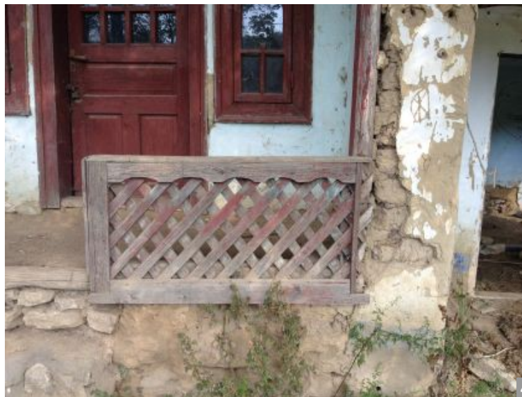
Soclu de piatră mai mare, lipită cu pământ, la o locuință realizată cu pereți din chirpici în satul Floriile, comuna Aliman, jud. Constanța.
