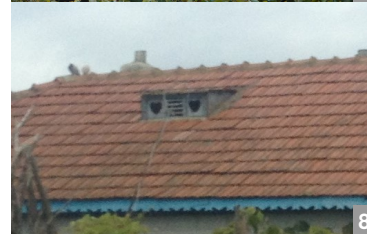
Lucarne, mici, cu rol mai mult de ventilație decât de iluminat.
