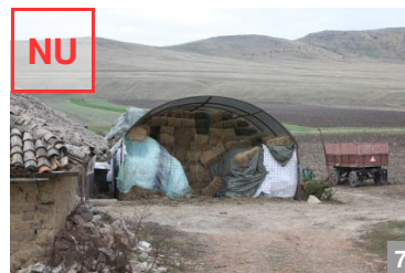
AȘA NU: Formă, material de construcție a șarpantei și învelitoare care nu au ce căuta în mediul rural
