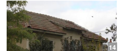
14 Rupere de pantă și înălțare a streșinii în dreptul prispei centrale, pe o treime din fațadă, după modelul lucarnelor (soluție relativ rară), în comuna Pantelimon, jud. Constanța
