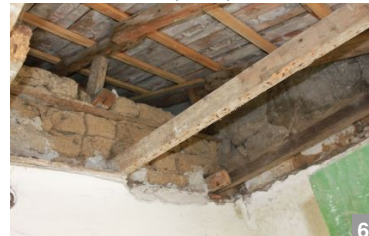
6 Șarpantă de lemn pe scaune, fără astereală, cu țigla așezată direct pe șipci.
