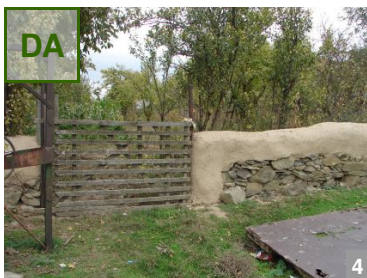
AȘA DA: Gard de piatră reparat cu lut și poartă reconșionată din lemn, în Runcu, jud. Conștanța.
