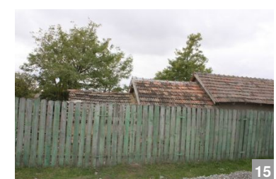
15 Descreștere graduală a înălțimii la construcțiile anexe, în comuna Pantelimon, jud. Constanța
