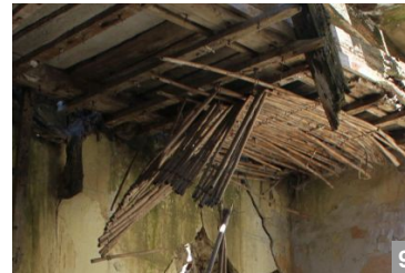
7 Structuri de tavane lutuite, din șipci de lemn una lângă alta, sau din stuf legat pe șipci mai rare, bătute sub căpriori.
