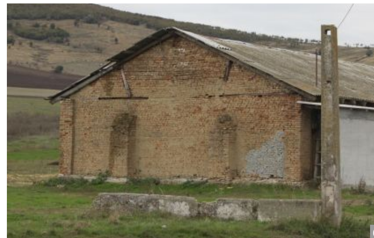
Construcție agricolă cu gabarit mare realizată integral din cărămidă, cu contraforți pentru rigidizare, în comuna Nicolae Bălcescu, jud. Constanța.
