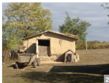
Grajd separat de casă, construit din chirpici, cu fundație de piatră, în comuna Saraiu, jud. Constanța.
