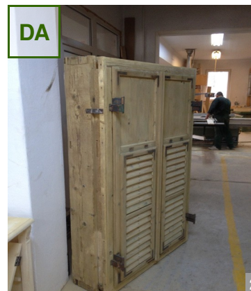
AȘA DA: Ferestrele tradiționale merită restaurate atunci când se prezintă în condiții acceptabile. Elementele degradate din lemn trebuie înlocuite, feneria făcută să funcționeze din nou, iar întreg ansamblul trebuie protejat de o peliculă de vopsea.
