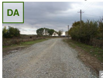
DA AȘA DA: Uliță pietruită. Avantajul este că o parte din apele meteorice se infiltrază în pământ, rigolele fiind mai puțin solicitate. Același avantaj îl are drumul de nisip.
