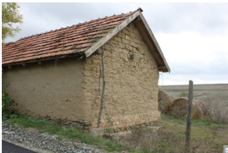
Anexă gospodărească zidită din chirpici, cu acoperiș în două ape și învelitoare din țigla, cu fronton tot din chirpici, în comuna Pantelimon, jud. Constanța.
