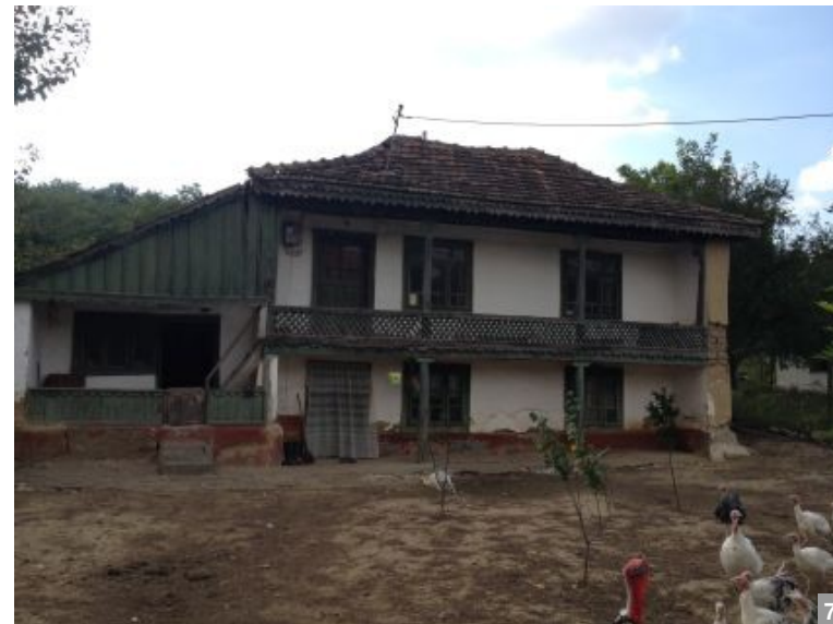
7 Ferește mari, cu câte trei canaturi la parter și cu supralumină la etaj, cu ușă mari cu geam, subîmpărțite în ochiuri cu șprosuri subțiri de lemn, în satul Floriile, comuna Aliman, jud. Constanța.
