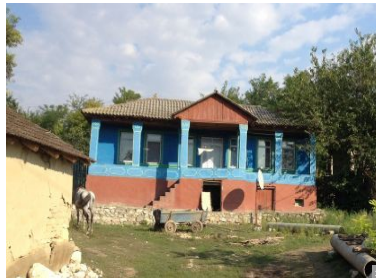
Casă cu demisol, prispă, foișor cu fronton de lemn, stâlpi și parapet înlocuite cu zidărie – Vlahi, Comuna Aliman, jud. Constanța
