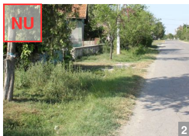
AȘA NU: Chiar dacă rigola este înierbată, vegetația mult prea dezvoltată trebuie tunsă regulat.
