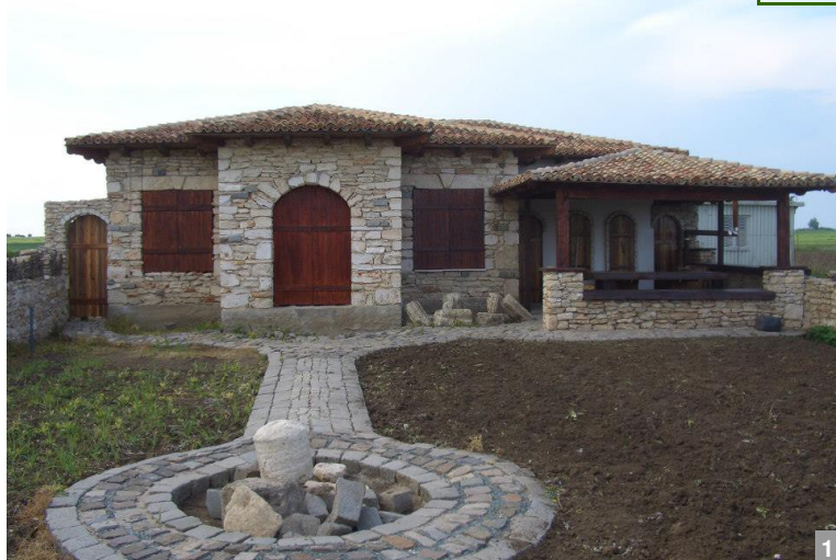
AȘA DA: Zidărie de piatră și elemente din lemn, care combină tehnica tradițională cu cea contemporană, pentru a corespunde cerințelor de stabilitate, etc..
