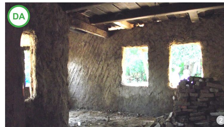
ASA DA: Restaurarea pereților din paiantă folosind materialele și tehnologia tradiționale.
