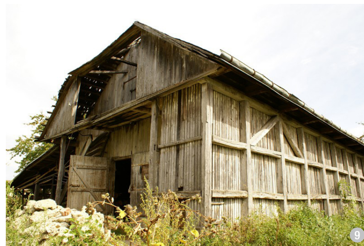
Construcție monovolum cu destinația de depozitare cereale – hambar, având pereții din lemn.
