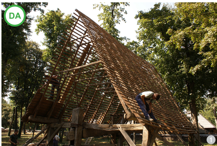
AȘA DA: Exemplu de rezolvare a unei șarpante din lemn în două ape.
