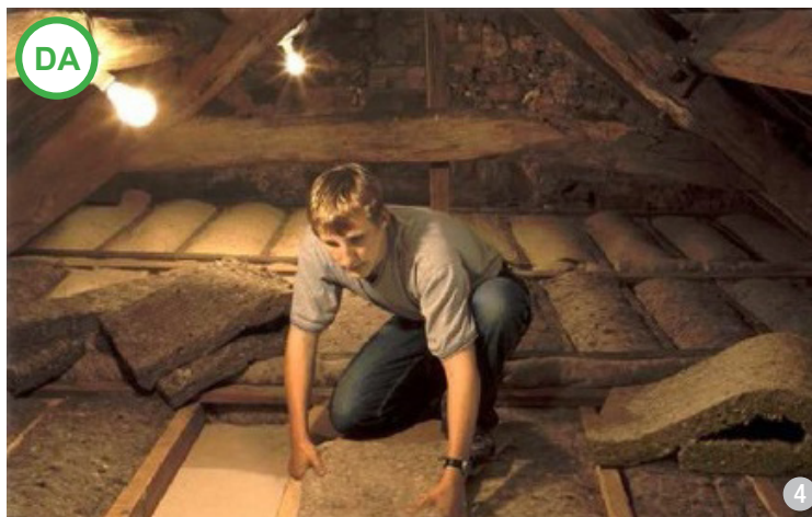
AȘA DA: Izolarea podurilor și a pardoselilor cu materiale ecologice este recomandată. În imagini, detalii de compunere.
