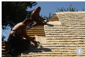
Exemplu de realizare a învelitorii de șindrilă – Casa George Enescu din Mihăileni.
