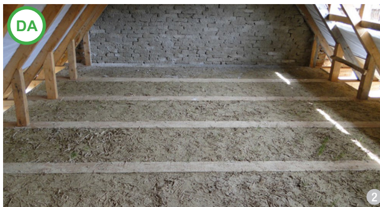
Tavan cu grinzi de lemn. Construcție cu pardoseală flotantă:
