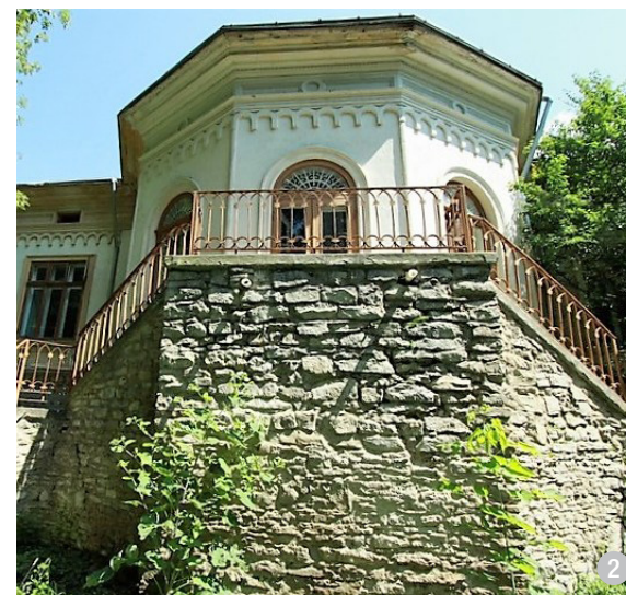
Soclu din zidărie de piatră, al unui conac.
