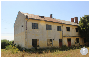
Construcție monovolum cu destinația de fabrică de produse ceramice, având pereții din cărămidă.
