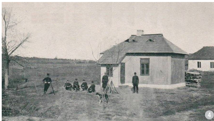
Înălțimea pereților mai mare decât cea a acoperișului.
