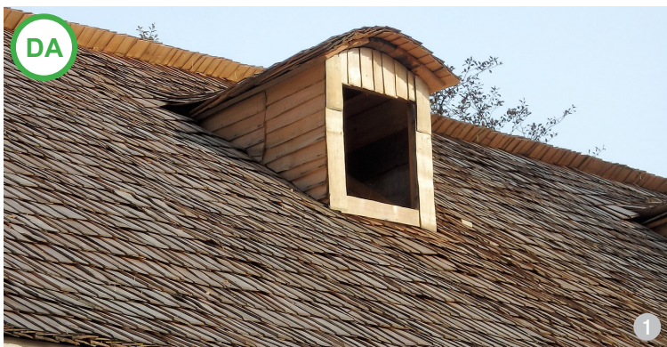
ASA DA: Reconstituirea lucarnelor și a învelitorii de șindrilă la o veche casă, în curs de restaurare.
