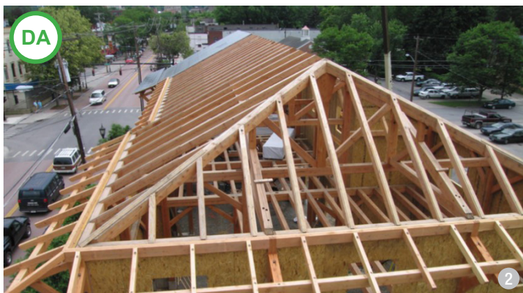
ÎNȘA DA: Șarpantă în patru ape care urmărește planimetria construcției.
