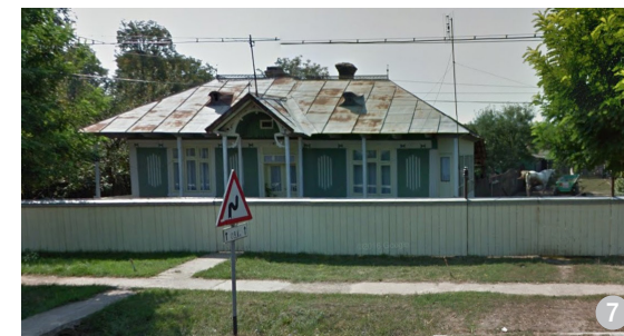
Acoperiș în patru ape, cu extensie în două ape peste foișor și învelitoare din tablă (comuna Brăești).
