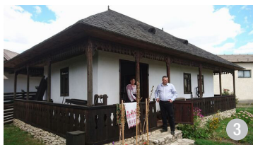
Prispă cu balustradă, pe cele patru laturi ale casei.
