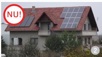
ASA NU: Acoperirea pe o suprafață mare, de peste 15 %, a învelitorii cu panouri solare (stânga) și panouri fotovoltaice (dreapta), vizibile din stradă, face ca acestea să influențeze într-un mod neplăcut imaginea de ansamblu a clădirii.
