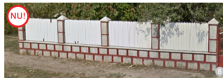
ASA NU: Împrejmuiri la stradă care nu respectă specificul local și au un impact negativ asupra ambientului, prin forme, materiale și culori nepotrivite.
