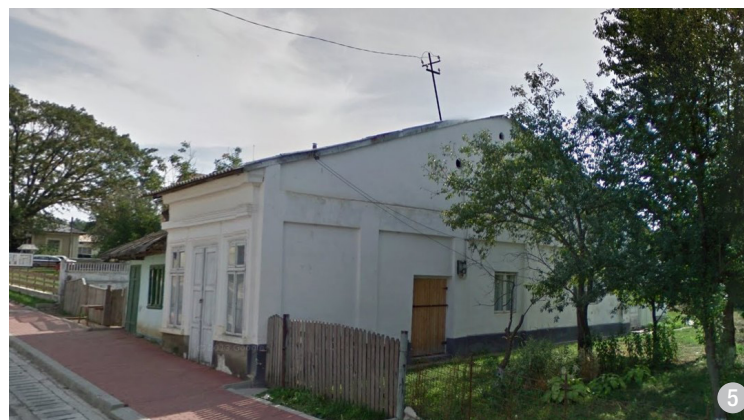
Acoperiș cu coama pe latura scurtă și învelitoare din tablă (comuna Mihăileni).
