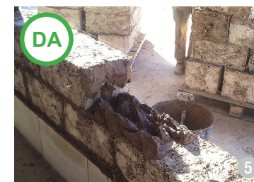
ASA DA: Case cu schelet din lemn și pereți din baloți de paie (4) sau cu pereți din blocuri de argilă amestecată cu paie (5).
