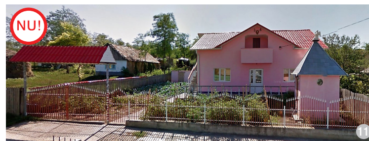
AȘA NU: Complicarea inutilă a acoperișului, asociată cu volumetria construcției, generează un efect neplăcut asupra imaginii de ansamblu.
