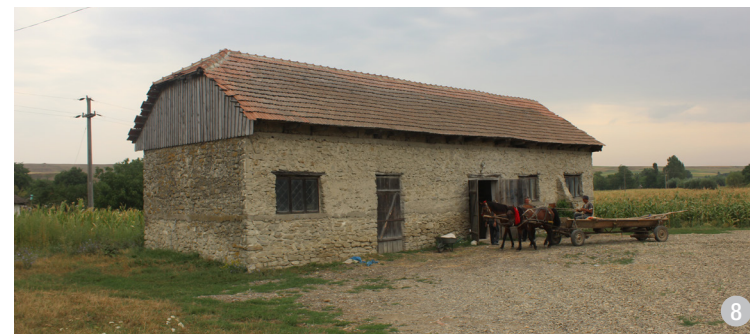
Construcție monovolum cu destinația de moară, având pereții din piatră și acoperiș din țiglă.
