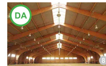
ASA DA: Utilizarea unei structuri din lemn lamelar sau zăbrele la nivelul șarpantei poate fi o soluție practică pentru clădiri cu deschideri mari..
