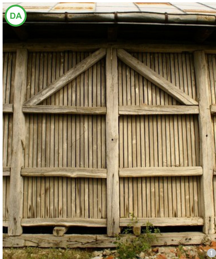
ASA DA: Perete din lemn, conservat, cu elemente structurale aparente, la o construcție anexă.
