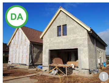
ASA DA: Casă cu structură de lemn și pereți din amestec de cânepă cu var - denumirea materialului este Hempcrete (Hemp-Lime).
