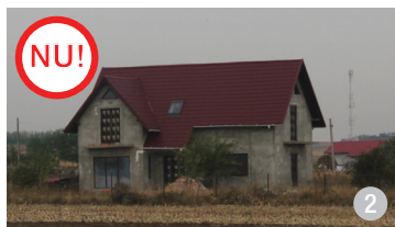
Închiderea spațiului semideschis al unei locuințe, cu tâmplărie și geam.
