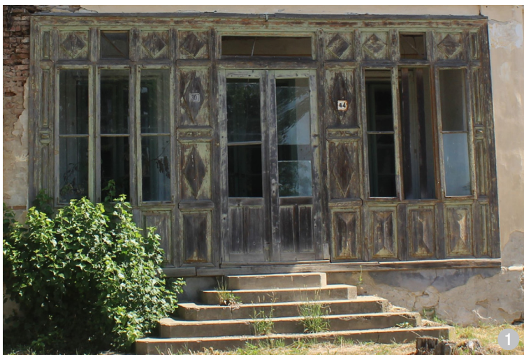
Închiderea spațiului semideschis al unei locuințe, cu tâmplărie și geam.
