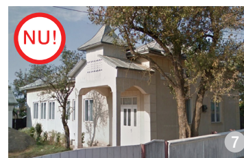
AȘA NU: Exemple de volumetrie neconformă cu tradiția locală, la acoperișurile unor clădiri noi: complicarea formei, supraînălțarea pe atic, inconsecvența compoziției.
