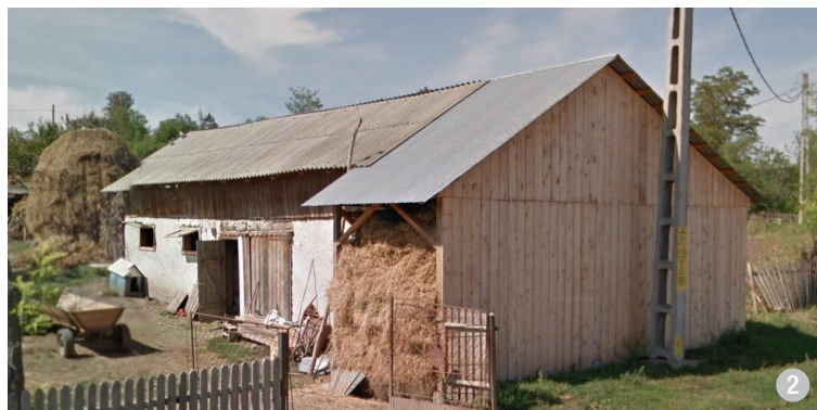
Exemple de construcții anexe gospodărești cu funcțiuni multiple.
