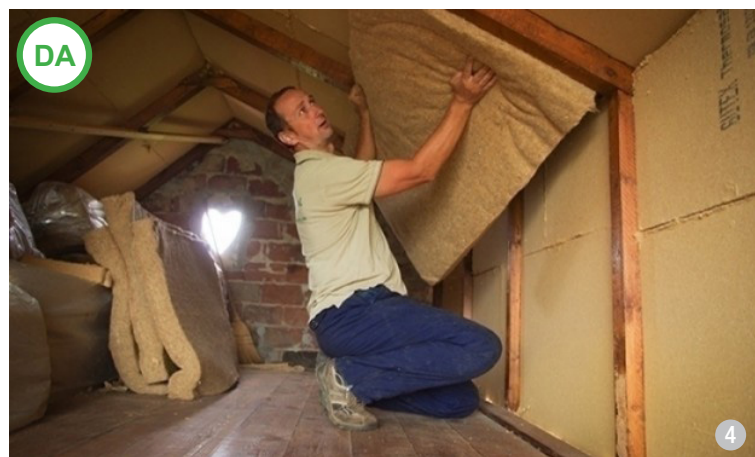
AȘA DA: Termoizolația din cânepă - montare rapidă și simplă. Nu este necesar un costum de protecție deoarece produsul nu irită pielea și nu conține substanțe periculoase mediului sau sănătății.
