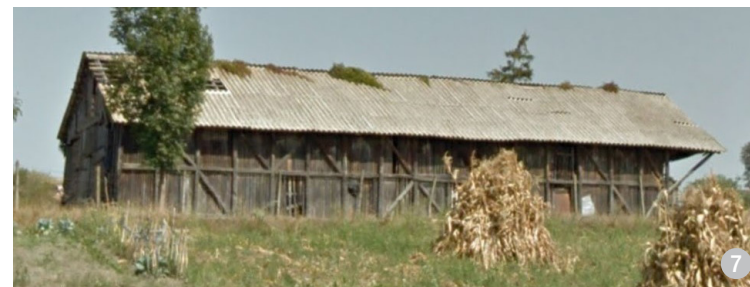
Construcție monovolum destinată depozitării cerealelor, amplasată în afara localității.
