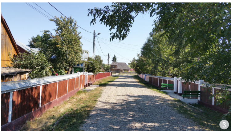
Imagine caracteristică a spațiului public rural din zonă: stradă pietruită, garduri cu bănci amplasate în dreptul acceselor, șanțuri de scurgere înierbate.
