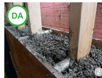
ASA DA: Casă cu structură de lemn și pereți din amestec de cânepă cu var - denumirea materialului este Hempcrete (Hemp-Lime).
