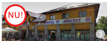
ASA NU: Forma acoperișului intră în totală contradicție cu noțiunea de încadrare în specific local și atrage după sine alte probleme, precum utilizarea contextuală a finisajelor.
