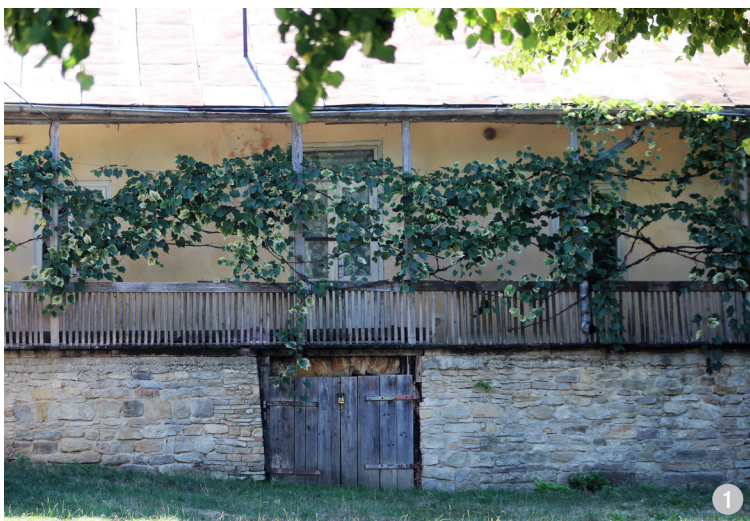
Soclu și pereții pivniței unei locuințe, executați din zidărie de piatră.
