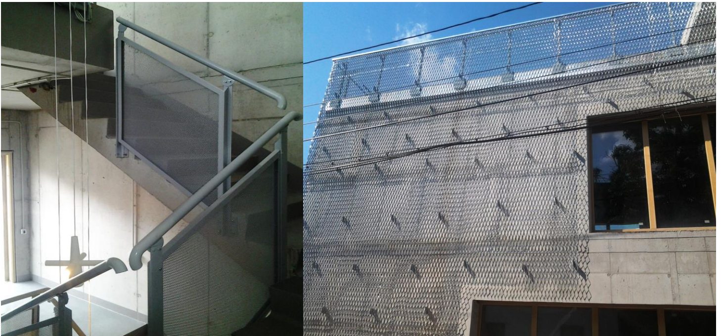
16. PLAFOANE SI PLACARE LIFT PROMENADA MALL BUCURESTI
