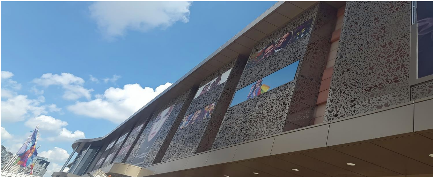
10. PLACARE SI PARAPET FAN CURIER BRASOV
