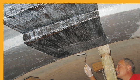
Consolidări structurale cu pânză și fibră de carbon
